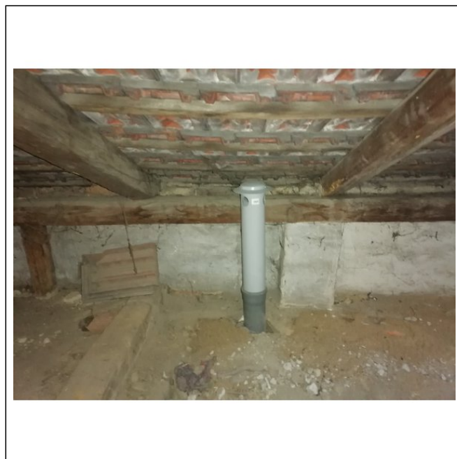
půda nad dvorním traktem-odvětrání podlah
