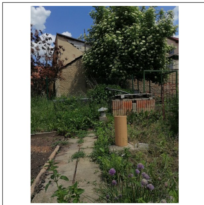
zahradu nad sklepem -vyústění odvětrání
