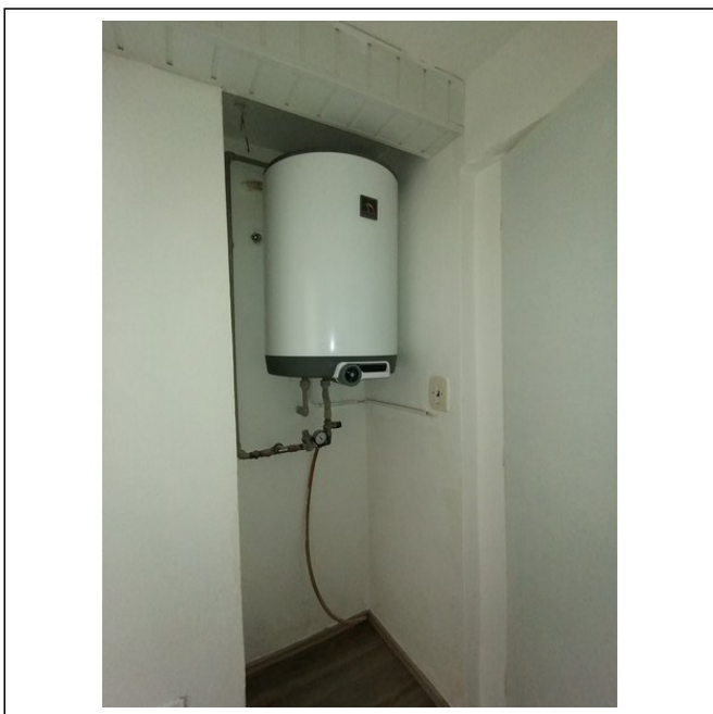
ohřívač vody (spojovací chodba)
