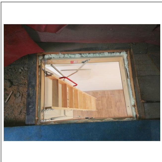
stahovací schody výlez na půdu (ul.trakt)
