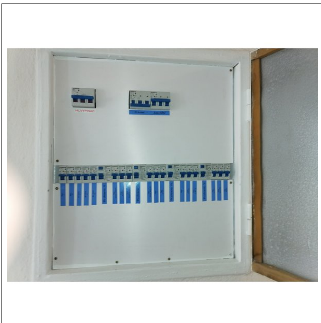
domovní rozvodnice s jističi
