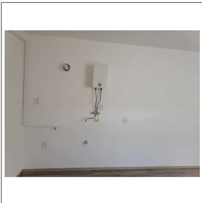
příprava instalací -pro napojení kuch. linky
