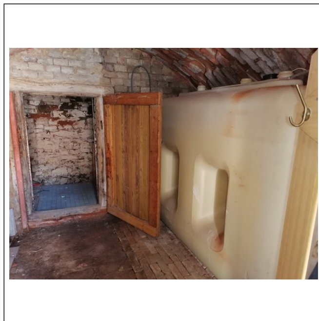
venkovní sklep-nádrže na dešťovou vodu
