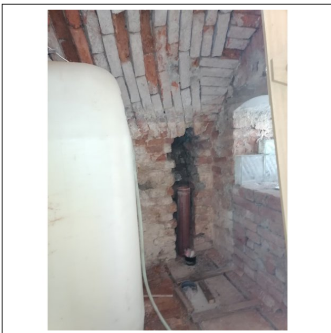
sklep- příprava odpadů
