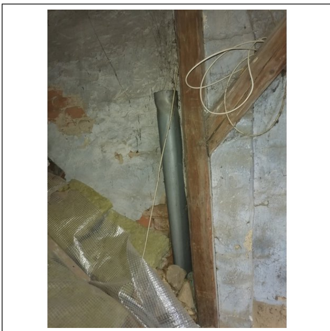
vyústění odtahu digestoře- půda nad dvorním traktem
